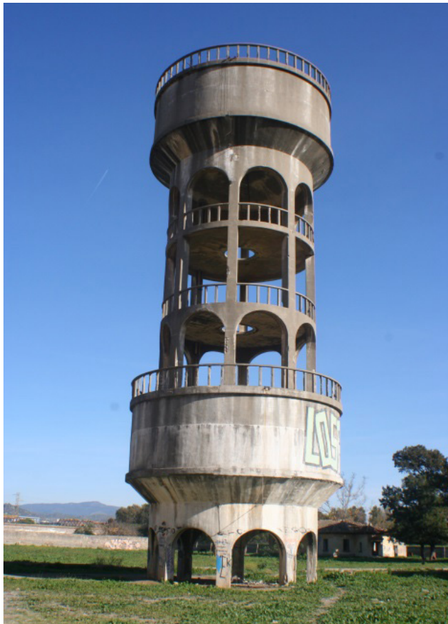
Figura 12. Depósito de aguas. Foto: Francisco J. Rodríguez Marín.
