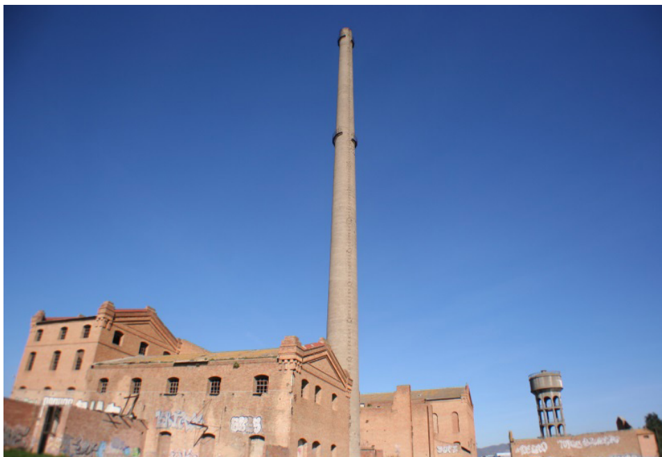
Figura 5. Vista general de la fábrica. Foto: Francisco J. Rodríguez Marín.
