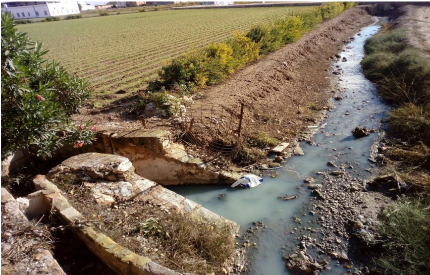
Figura 3. Aguas contaminadas en una de las acequias de la Partida de Vera (Benimaclet). Fotografía de los autores (2019). 3
