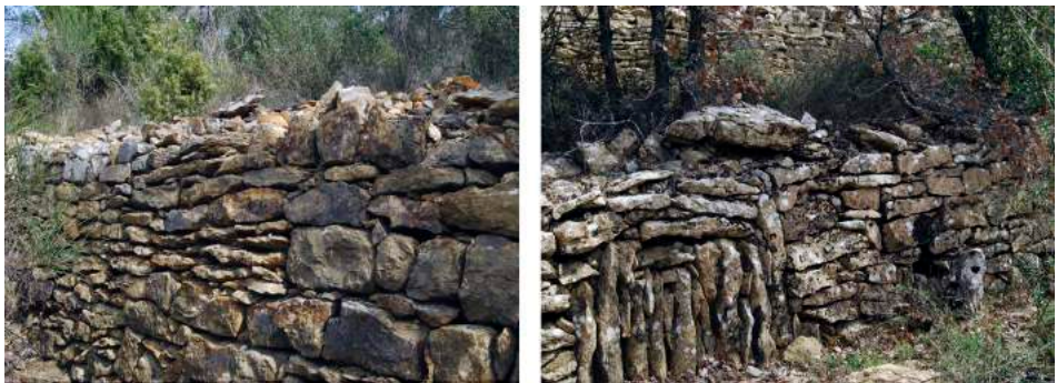
Figure 12. Exemples d'appareils différenciés qui se suivent sur les mêmes parements: moellons orthogonaux et dalles courtes, b) arrangement complexe de dalles longues et de moellons en alternant assises horizontales et verticales. Photographies: (C) ASER.
