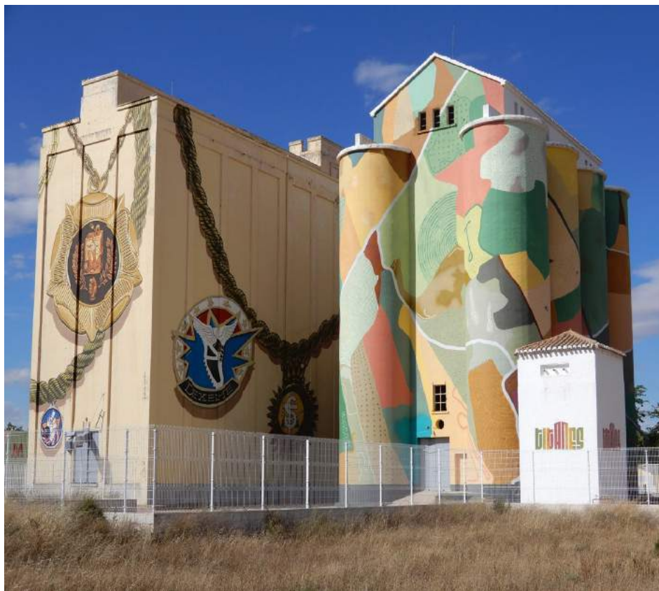
Figura 7. Complejos de Silos de Manzanares I (derecha) y II (izquierda). Fuente: M. Carmen Cañizares (2020).
