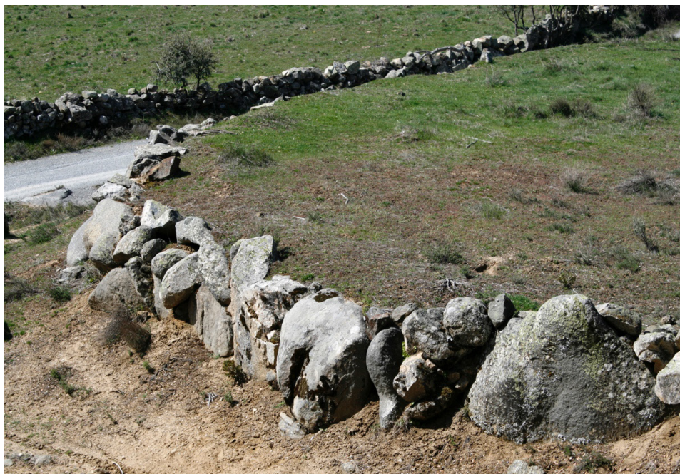
Figura 6. Bancal individual con muros de piedra seca en Tórtolos. Fotografía: Autores.
