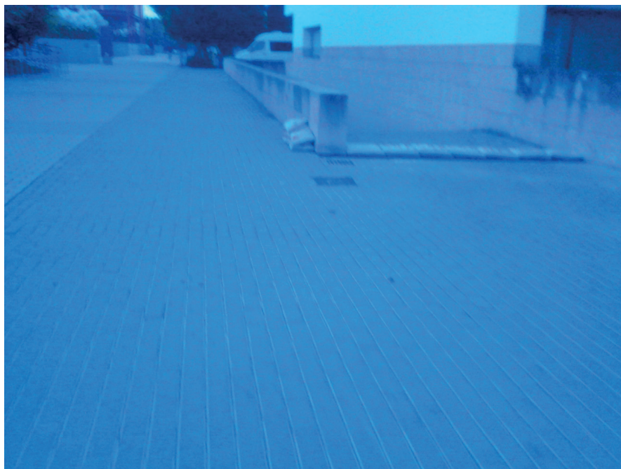
Figura 2 Medida de mitigación del riesgo de inundación en la entrada del parking del Rectorado. Foto de los autores.
