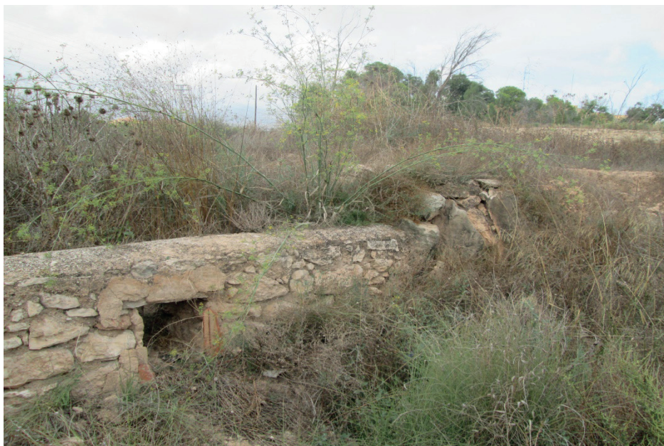
Figura 6. Presa de derivación de las «Casas de las Cisternes» (Cañada de Canastell). Foto de los autores.
