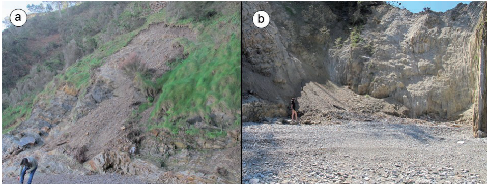
Lámina 3. a) Deslizamiento cuyo depósito ha sido barrido por la marea, obsérvese la cicatriz de arranque en la parte superior [fotografía tomada en enero de 2016]; b) Movimiento en masa mixto originado en el sector occidental de la playa cuyo depósito aún no ha sido redistribuido [fotografía tomada en mayo de 2016].
