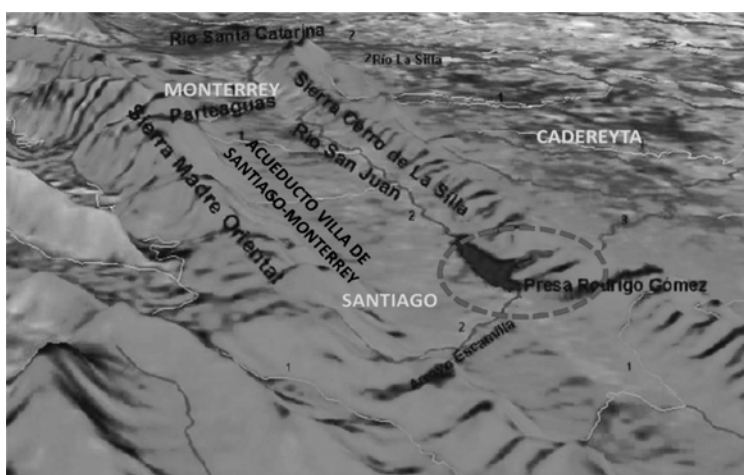
Figura 4. Presa «La Boca»
