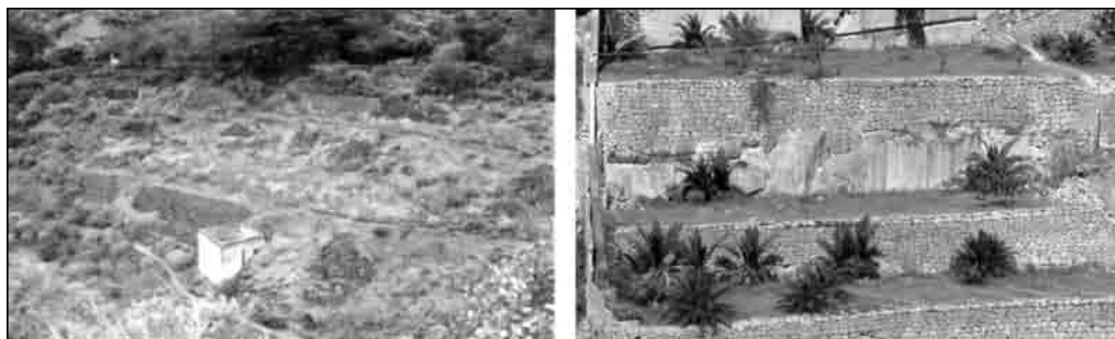
Fotografía 2. Estados de conservación de los bancales del Guiniguada.
