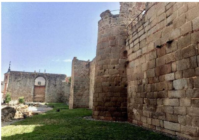
Figura 5. Vista de detalle de la muralla tardoantigua de Talavera de la Reina (Sector de *El Charcón*). Mostrando la alternancia de torres cuadrangulares y de planta circular, con sillares reaprovechados de época altoimperial. Al fondo, la gran torre albarraña medieval, que forró, integrándola, una de las torres tardoantiguas de planta cuadrangular. Fotografía: elaboración propia.
