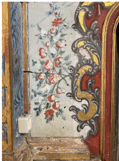
Figura 7. Instalación eléctrica adosada a la mazonería del retablo de san Francisco.
