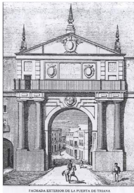
Figura 5. Bartolomé TOVAR (1878). Puerta de Triana, grabado no 12. Fuente: TOVAR (2001) «Las puertas de Sevilla en dibujos de B. Tovar», en Las puertas de Sevilla en dibujos de B. Tovar . Colegio Oficial de Aparejadores y Arquitectos Técnicos de Sevilla.
