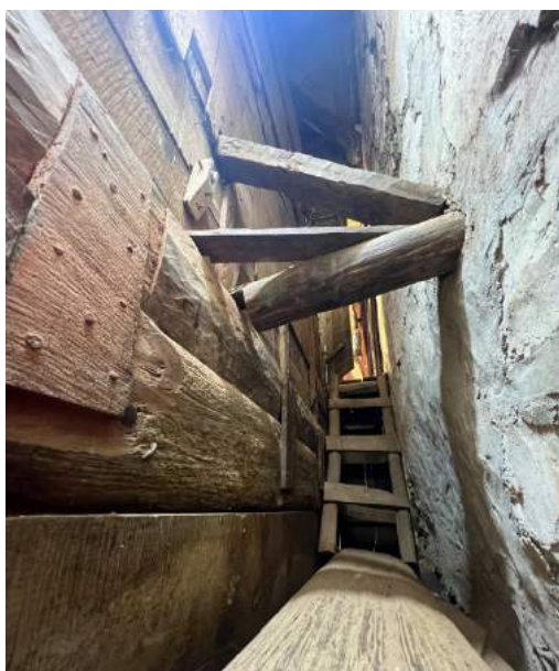
Figura 4. Riosra localizada a la altura del segundo cuerpo, en el lateral de la epístola, del retablo mayor de la iglesia de San Francisco.
