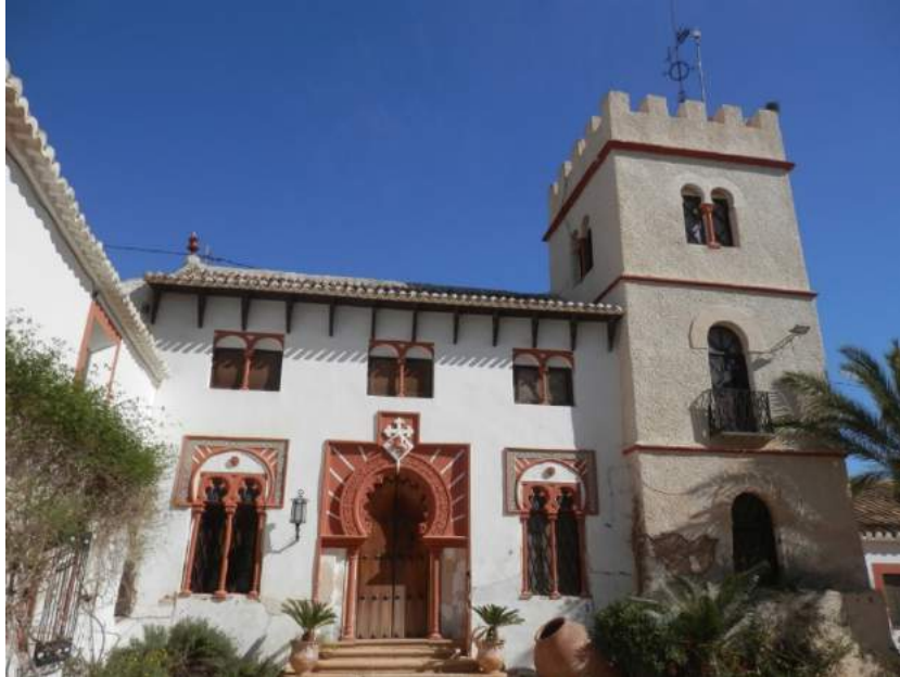
Figura 4. Casa principal de la Hacienda Corverica. Fuente: autor
