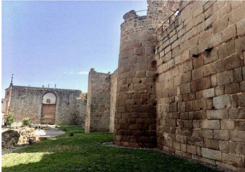
Figura 5. Vista de detalle de la muralla tardoantigua de Talavera de la Reina (Sector de El Charcón ). Mostrando la alternancia de torres cuadrangulares y de planta circular, con sillares reaprovechados de época altoimperial. Al fondo, la gran torre albarana medieval, que forró, integrándola, una de las torres tardoantiguas de planta cuadrangular. Fotografía: elaboración propia.
