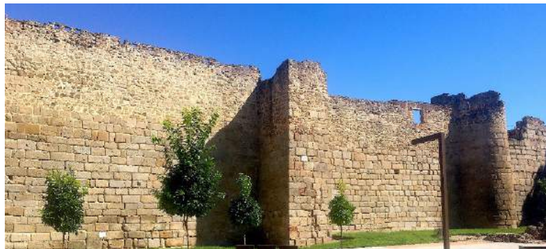
Figura 4. Vista de la muralla tardoantigua de Talavera de la Reina (Sector de El Charcón ). Mostrando la alternancia de torres cuadrangulares y de planta circular, con sillares reaprovechados de época altoimperial. Fotografía: elaboración propia.
