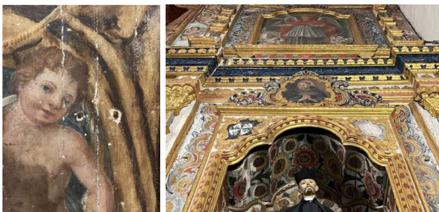
Figuras 8 y 9. Alteración de la capa policroma por oxidación de clavos y variaciones cromáticas en los elementos inclinados del retablo de lámina. Retablo de la Iglesia de San Francisco
