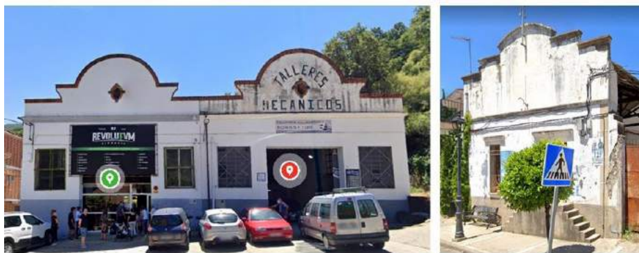
Figura 6. Fachadas de talleres en carretera Soria-Plasencia, Navaconcejo. Fuente: Google, s.f. [Recuperado el 21 de mayo de 2022 de https://tinyurl.com/2mlhc2yb ]. Y fachada de edificio de almacén en ruinas en carretera Soria-Plasencia nº 83, Jerte (Google, s.f. [Recuperado el 21 de mayo de 2022 de https://tinyurl.com/2lskgaqt ]).
