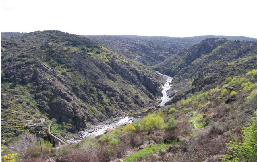
Figura 2. Encajamiento o arribe del curso fluvial del río Águeda a su paso por el Puente de los Franceses, entre los términos municipales de Puerto Seguro y San Felices de los Gallegos. Fuente: elaboración propia.
