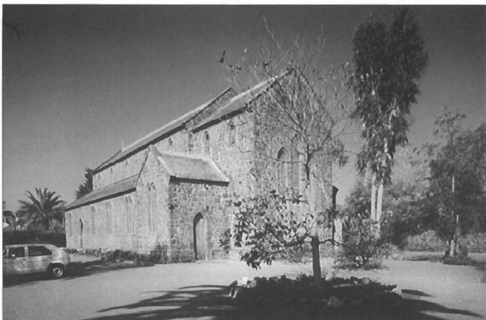
Estado actual de All'Saint del Puerto de la Cruz (Tenerife).
