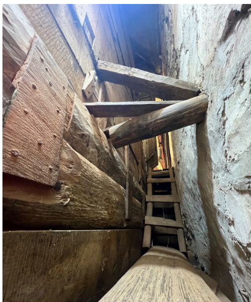
Figura 4. Riostra localizada a la altura del segundo cuerpo, en el lateral de la epístola, del retablo mayor de la iglesia de San Francisco.
