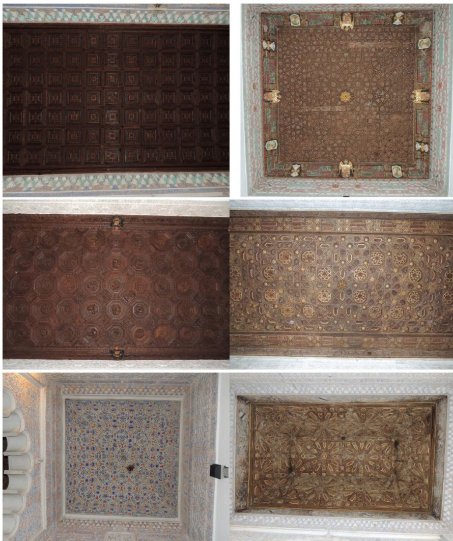
Figura 9. Zaquizamies en el Real Alcázar de Sevilla. Izquierda: de madera con artesones cuadrados y octogonales, y de yeso. Derecha: de madera con lacería (María Núñez-González).
