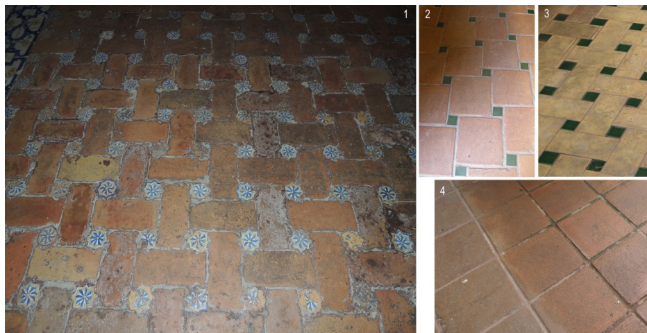
Figura 5. Fotografías de olambrillas y mazaríes. 1. Suelo de una cámara en el Real Alcázar con olambrillas en forma de estrella. 2. Suelo olambrado de mazaríes. 3. Suelo ladrillado olambrado. 4. Suelo de mazaríes (María Núñez-González).
