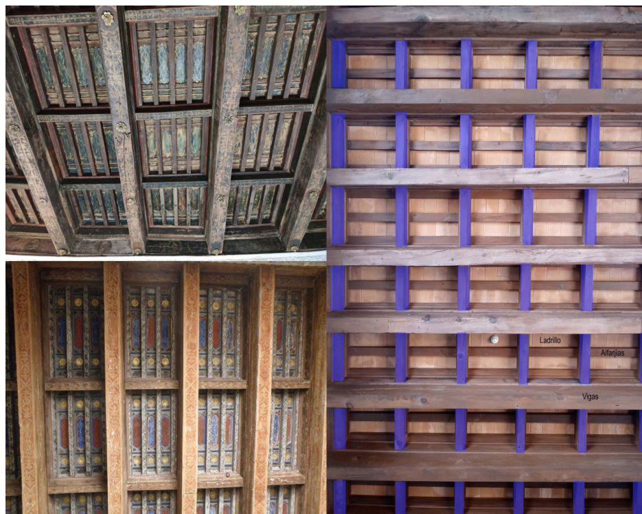
Figura 7. Izquierda (conservadas): arriba techo de la actual sala de revistas, casa Pinelo. Sevilla, Pedro BARRERO (2021); abajo: techo de una estancia en la Casa Pilatos. Sevilla, María NÚÑEZ (2017). Ambas techumbres con vigas (pinos), almojairas y alfarjías. Derecha (siglo xx): techumbre compuesta por vigas, almojairas (azul), alfarjías y ladrillo por tabla, Casa Mañara (María Núñez-González).
